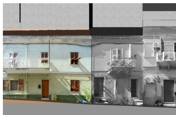
Profilo stato attuale (fotoraddrizzamento)
