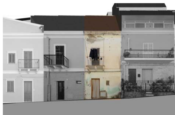
Profilo stato attuale (fotoraddrizzamento)
