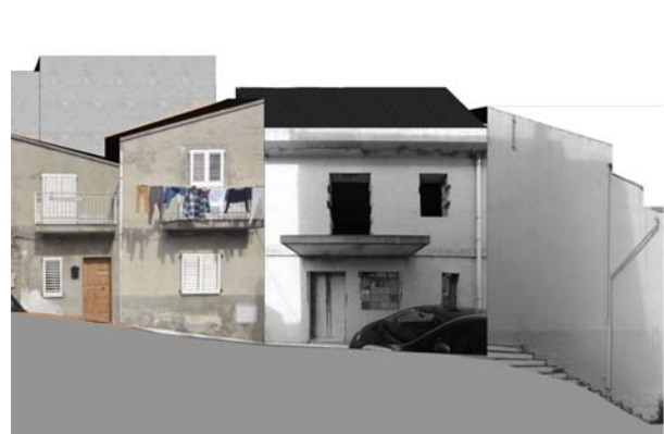
Profilo stato attuale (fotoraddrizzamento)
