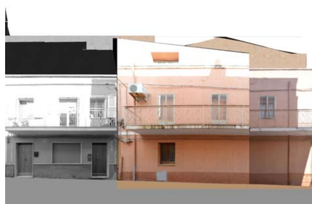
Profilo stato attuale (fotoraddrizzamento)
