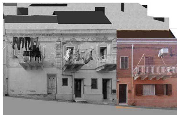
Profilo stato attuale (fotoraddrizzamento)
