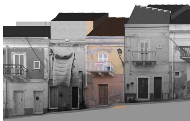
Profilo stato attuale (fotoraddrizzamento)
