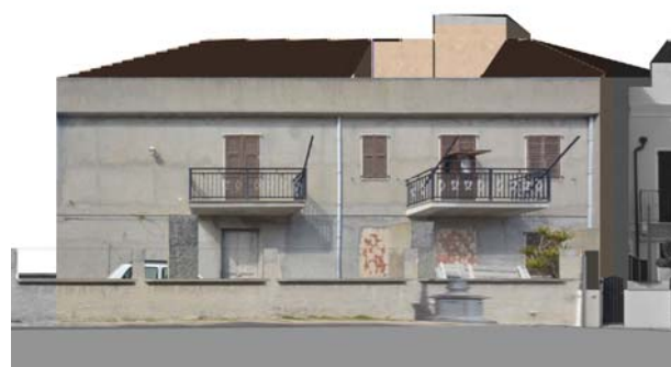
Profilo stato attuale (fotoraddrizzamento)
