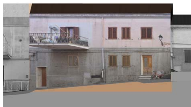
Profilo stato attuale (fotoraddrizzamento)
