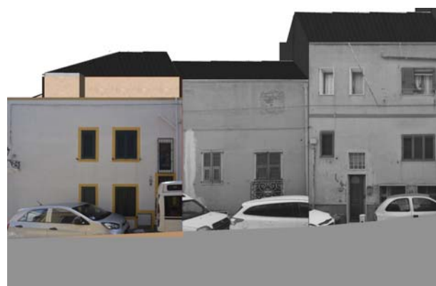
Profilo stato attuale (fotoraddrizzamento)
