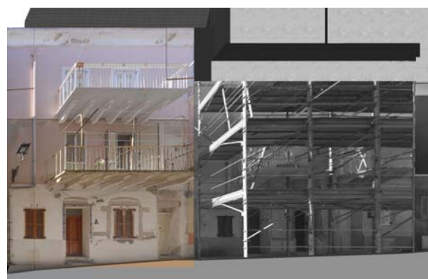
Profilo stato attuale (fotoraddrizzamento)
