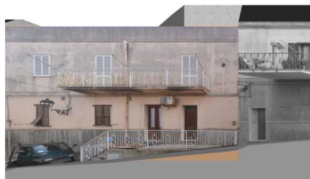
Profilo stato attuale (fotoraddrizzamento)
