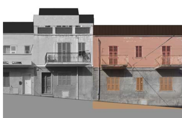
Profilo stato attuale (fotoraddrizzamento)
